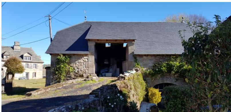
La « montade » compense un défaut de relief sur cette grange auvergnate. Crédits : Cittànova
