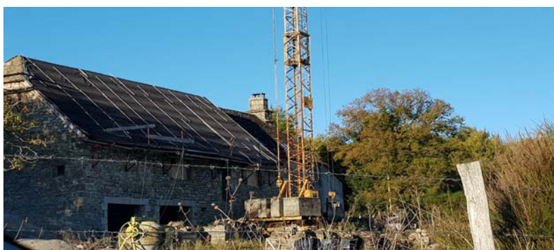
Rénovation d'une toiture à Hautefage
