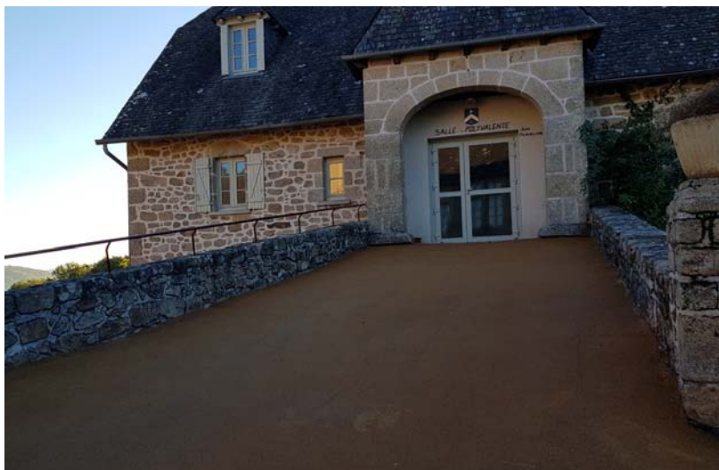
Changement de destination de cette ancienne grange en salle polyvalente et restauration du revêtement au sol, Hautefage
