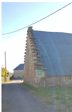
Pignon à pas d'oiseau, Saint-Cirgues-de-la-Loutre
