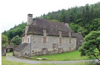
Illustration 24: Patrimoine remarquable non classé à Saint-Bazile-De-La-Roche
