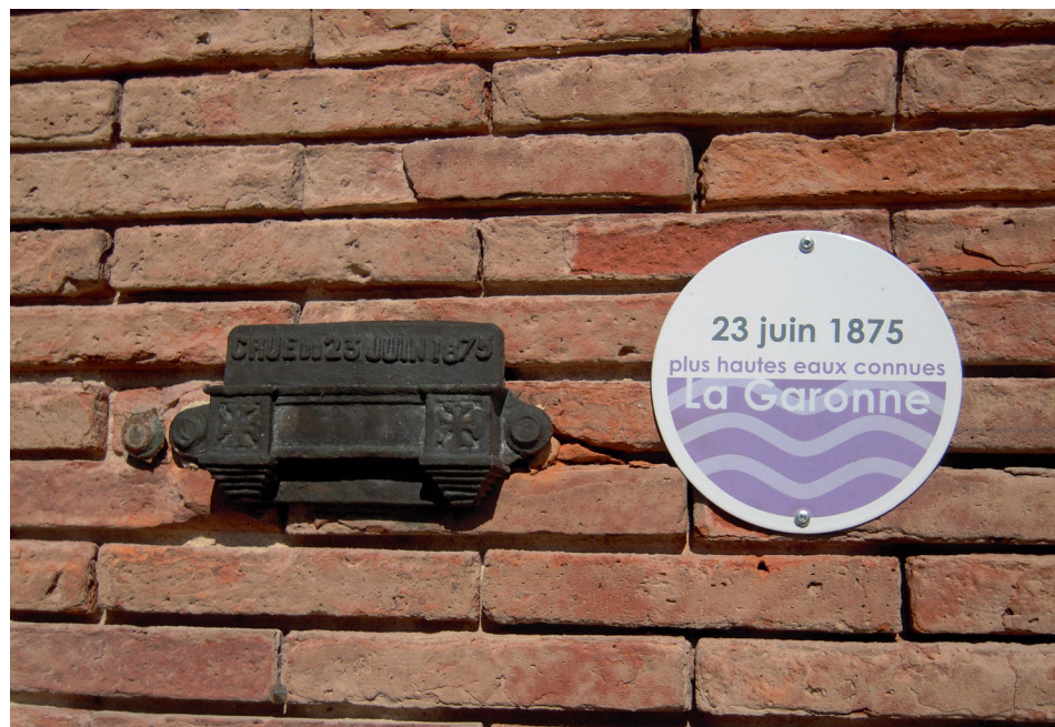
Repère de la crue de juin 1875 à Toulouse Photo : Ville de Toulouse
