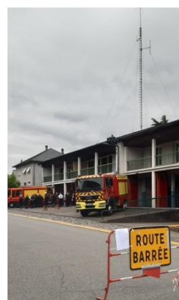
Vue de la caserne SIS centre bourg, ave des Xaintries
